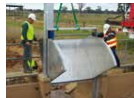
Instalación en seco
